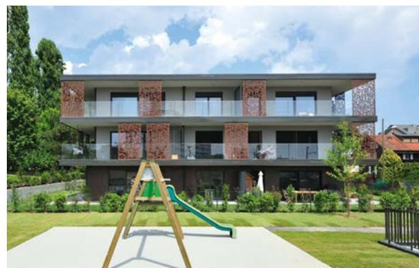
**RÉALISATION** > De facture traditionnelle, le bâtiment est protégé par une isolation périphérique, chauffé par une pompe à chaleur air-eau, équipé de panneaux photovoltaïques en toiture. Les ouvrants sont équipés de triples vitrages et les appartements du rez-de-chaussée de vitrages sécurisés. Visiophones et digicodes assurent la tranquillité des habitants.
