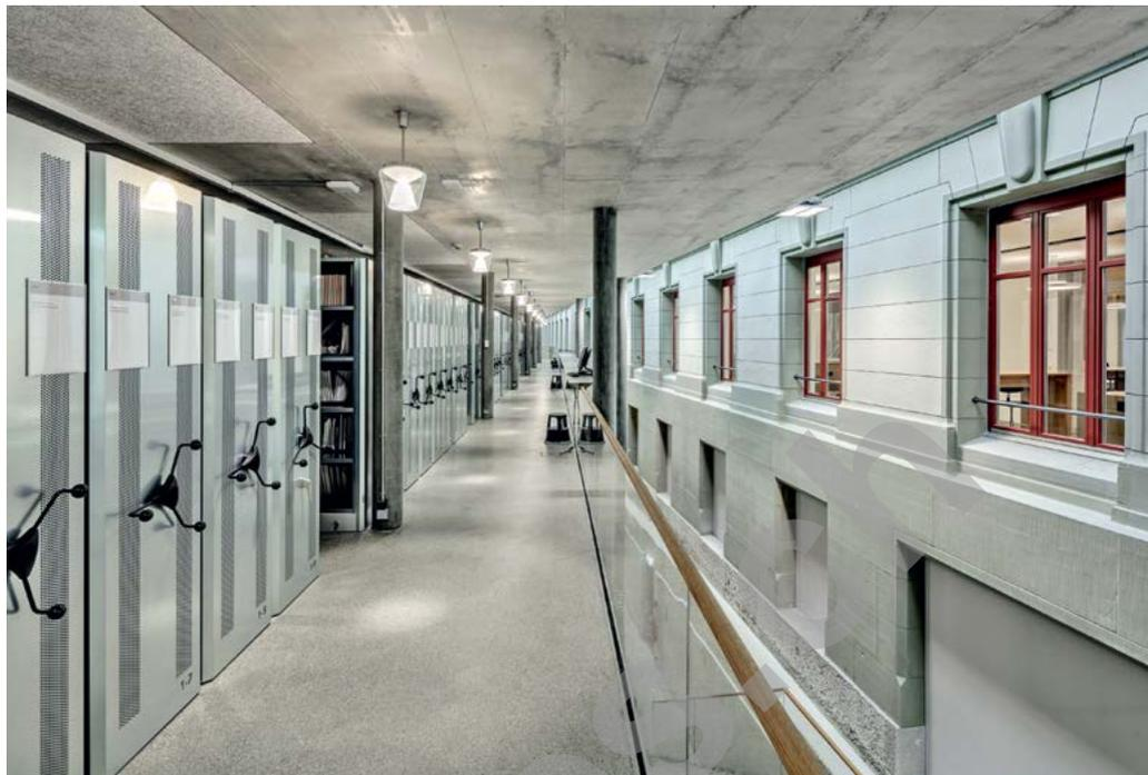
Bei der Sanierung blieb die Aussenfassade erhalten. Sämtliche Fenster sind neu verglast, nicht originale und nicht mehr nötige Elemente wurden entfernt. Farben und Materialisierung orientieren sich an der ursprünglichen Gestaltung. Historische Details wie Gussssäulen, Kassettentüren und deren Zargen sind erhalten.
