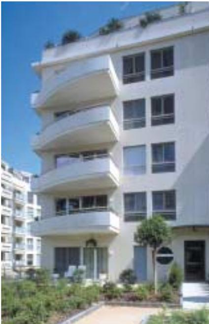
concrétisée grâce au choix d'un système porteur essentiellement périphérique, complété par quelques éléments ponctuels intermédiaires ; la disposition des gaines techniques, soigneusement étudiée, participe également à l'obtention de cette souplesse d'aménagement.
