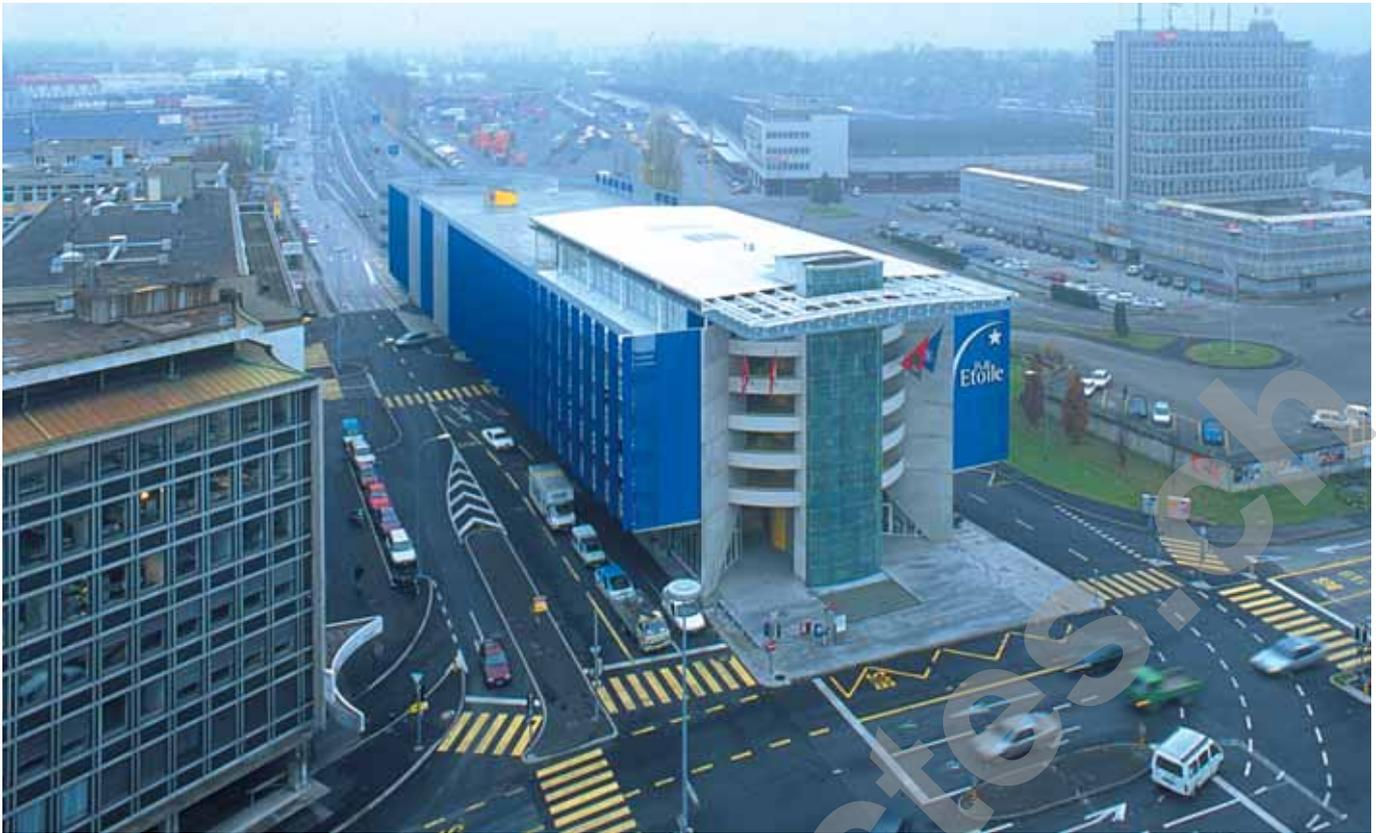
rythmées par des panneaux métalliques verticaux profilés en "aile d'avion", il rompt avec la géométrie arrondie de la rampe d'accès et s'affirme de façon élégante et changeante en fonction de l'angle d'observation, tout en offrant l'avantage de volumes aérés et éclairés naturellement. La conjugaison de ces panneaux métal-
