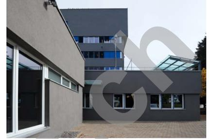
Le bâtiment de 1973 avait été construit en béton-armé avec des panneaux en béton préfabriqué pour les contre-cœurs. Une isolation périphérique de 24 cm y a été fixée. Les vitrages sont remplacés par des triples verres sur cadre PVC avec un Ug de 0,7 W/m2K.
