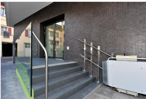
les menuiseries existantes ont été maintenues et les verres isolants remplacés par des éléments plus performants ; un vitrage fixe avec venelles pivotantes a été mis en place devant les vitrages; une isolation périphérique en polystyrène, revêtue de carrelage a été posée sur la façade existante. Cette intervention, entièrement réalisée par l'extérieur, a permis de ne jamais interrompre l'exploitation des locaux.
