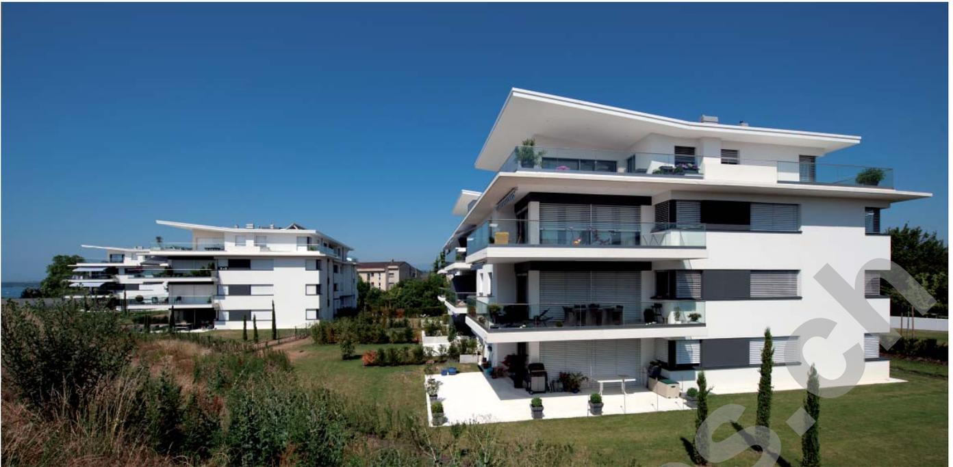
L'architecte a voulu renforcer les lignes horizontales pour diminuer l'impact en hauteur du milieu bâti. Les bâtiments débordant côté Sud, l'acrotère périphérique sur 2ème étage et la dalle de toiture sont des ailes de légèreté sur les formes rigoureuses du volume des immeubles. Le jeu dérodant des baies vitrées renforce à la fois l'ouverture sur le dégagement en favorisant la lumière naturelle, tout en protégeant les espaces extérieurs entre eux.
