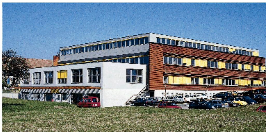
Les noyaux fixes, en béton armé, qui réunissent tous les éléments de services (circulations verticales, sanitaires et gaines techniques) marquent la tête du bâtiment et servent de contreventement à l'ensemble. Le volume principal de forme rectangulaire est surmonté d'un niveau d'attique, et est percé en son centre d'une généreuse cour, destinée notamment à l'apport de lumière naturelle.
