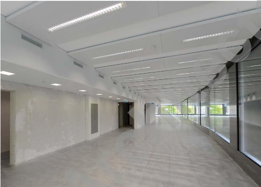
La pose d'une nouvelle façade en verre avec les techniques de dernière génération et les aménagements intérieurs des espaces. La façade est une double peau constituée d'un verre simple, de la paroi avec stores intégrés et d'un triple verre. Chaque vitrage est un élément de trois mètres par trois mètres. À l'aide d'une grue, ils ont été glissés depuis la toiture entre les échafaudages et la façade et ont ainsi été empilés les uns sur les autres.
