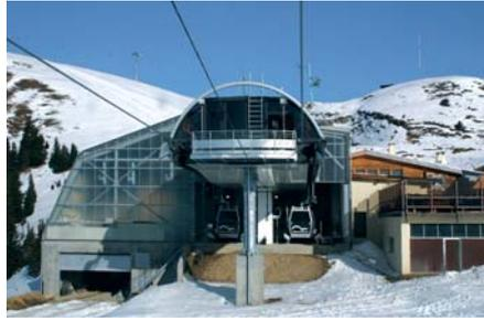
ère utilitaire des bâtiments, les détails sont tous simples, pour ne pas dire rudimentaires, et les matériaux souvent laissés bruts. Les 2 stations sont ainsi constituées d'un socle en béton laissé apparent surmonté d'une charpente et d'un bardage métallique. Des faces entières, notamment en station haute, ont été réalisées en polyester transparent afin de laisser entrer la lumière.
