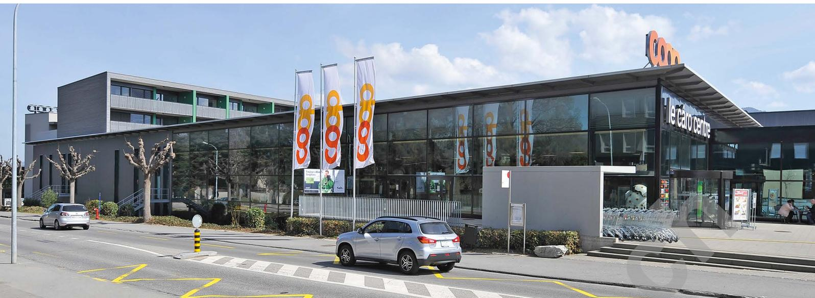
l'ensemble est assurée par trente mille goujons scellés selon une grille de répartition précise. Ce renforcement est complété par des bandes de carbone collées sur la face inférieure des sommiers de la dalle. Afin de supporter le poids des logements ajoutés sur la toiture, une dalle de répartition précontrainte de septante centimètres d'épaisseur a été mise en œuvre.
