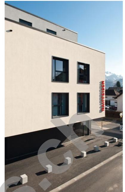
Constructivement, la structure porteuse (murs, piliers et dalles) est entièrement en béton armé. Une isolation périphérique crépie ou revêtue de carrelage en grès cérame pour le socle et des vitrages à cadres métalliques noirs complètent l'enveloppe. La production de chaleur se fait par raccordement au réseau de chauffage à distance de la commune de Bulle.
