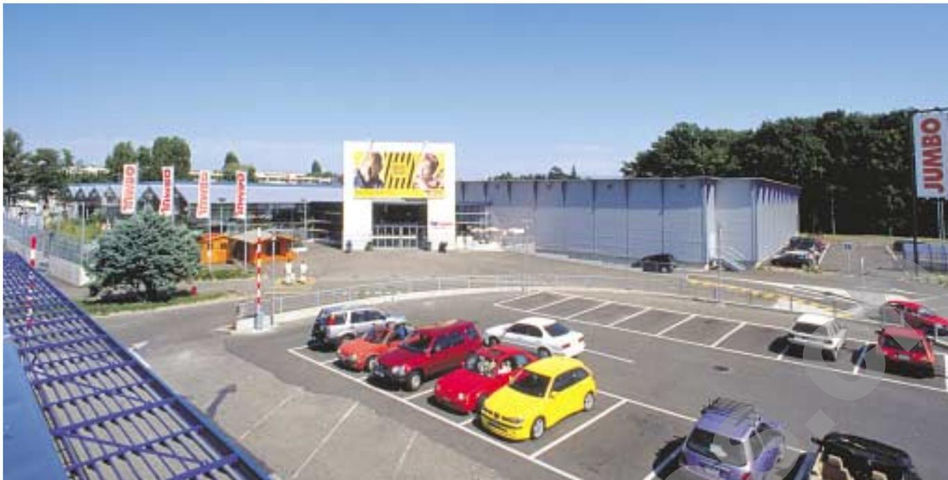
de façades métalliques constituées de panneaux sandwich isolés à l'intérieur et garnis de tôles de bardage à l'extérieur.
