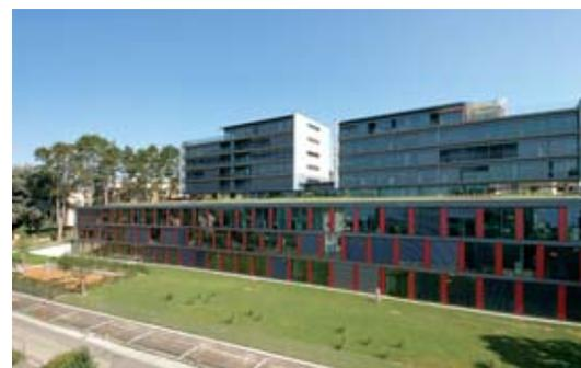
Construits sur un large socle qui détermine le rez côté nord et qui ouvre deux niveaux côté aval, face au sud, les immeubles sont basés sur une structure piliers-dalles traditionnelle. A l'instar du bâtiment Tschumi cité plus haut, ils sont conçus de telle manière que le rez reste libre d'obstacles, assurant ainsi, à ce niveau, une grande transparence et le dégagement visuel vers le lac et les Alpes.
