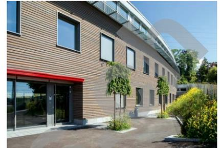
Le choix du bois (mélèze pré-grisé) pour le parement des façades s'est effectué après de nombreuses recherches et vérifications. Elles ont notamment débouché sur l'application complémentaire d'un traitement qui permettra d'uniformiser la modification de teinte due au vieillissement et à l'exposition déséquilibrée des façades aux UV, aux intempéries et à la pollution ambiante.
